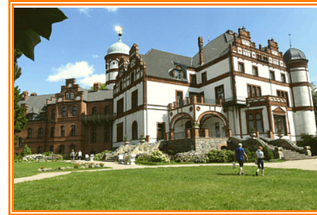
Abb. 3: Teilansicht vom Schloss Wiligrad aus südlicher Richtung
