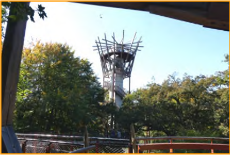
Abb. 6: Blick vom Baumkronenpfad auf den Aussichtsturm mit Außentreppe zur Aussichtplattform
