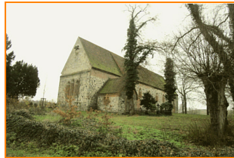
Abb. 2: Ansicht der turmlosen Kirche aus nordwestlicher Richtung
